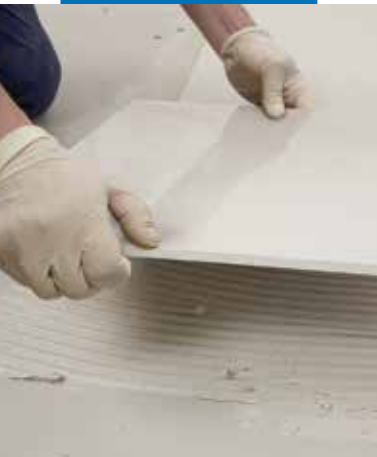
Colocación del gres porcelánico con Keraflex Extra S1
