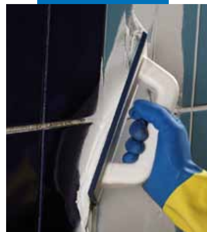
Aplicación en pared de Kerapoxy CQ con llana MAPEI
