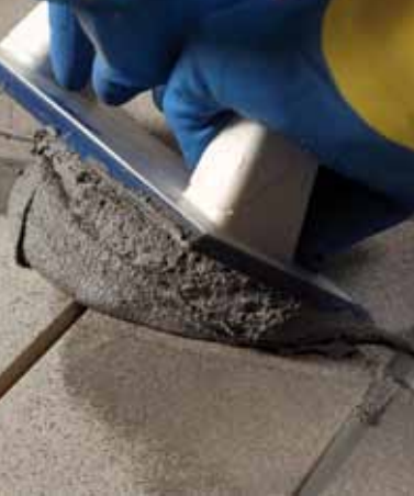
Aplicación de Kerapoxy CQ con llana MAPEI
