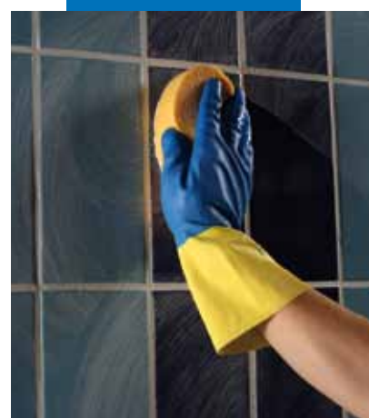
Limpieza y acabado con esponja dura de celulosa
